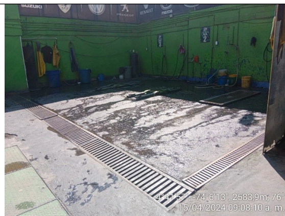
Foto No.4. Área de lavado y rejillas perimetrales
